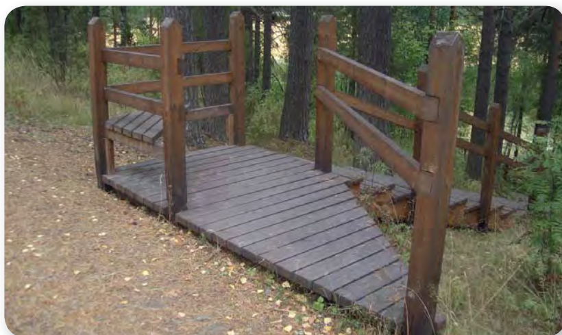
Kuva 55. Muistomerkin kohdalta johtavat portaat alas Kyyhkylän pellon reunan. Portaat ovat osa ulkoilureittiä.
