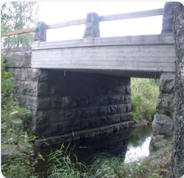
Kuva 31. Porrassalmentien kunnostettu silta
