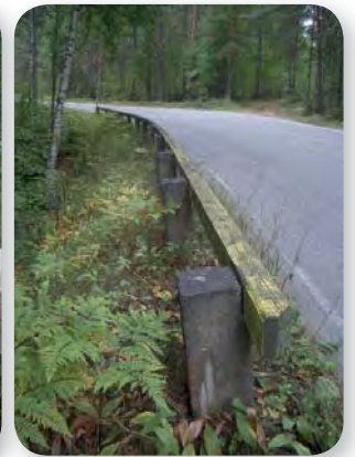
Kuvat 50 ja 51. Porrassalmentiellä on sekä graniittisia että betonirakenteisia tiekaiteita, joissa johde on puuta. Osa johteista on uusittu.
