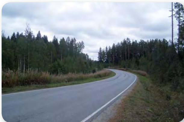
Kuva 23. Näkymä Porrassalmentie uudelta tielinjalta tien eteläpäässä
